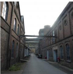
Industriestraß e in der ehem. Fabrik Wülfing
