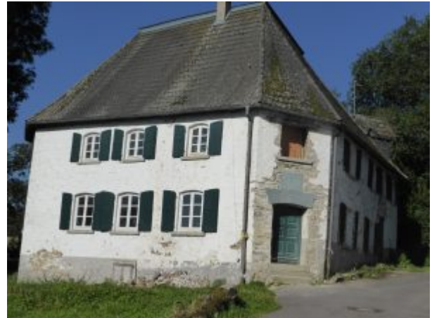
Burg Helberg in Renovierung
