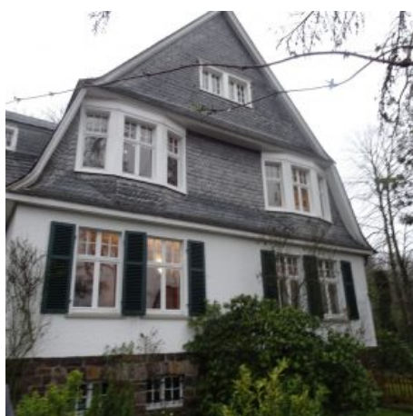
Villa Wollenweber – Architekt H. Kiefer
