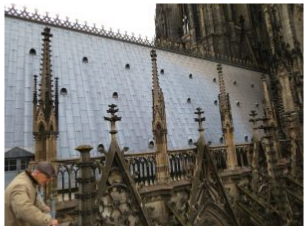
Fialen und Bleidach des Langhauses
