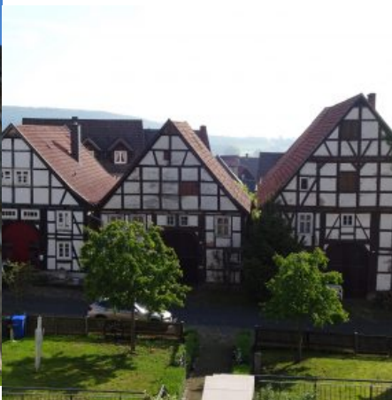
Alte Fachwerkhäuser in Rhoden
