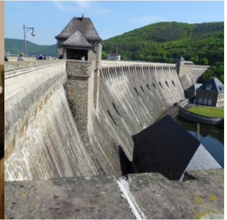
Staumauer der Edertalsperre
