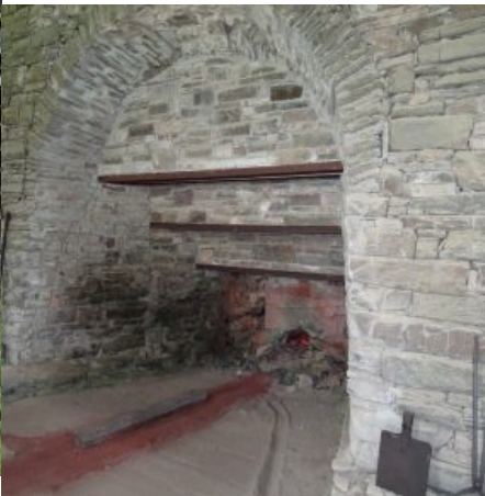
Auslaufbereich des Hochofens
