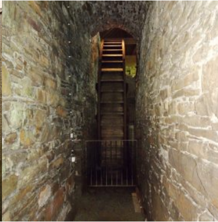
Wasserrad zum Antrieb von Hämmern und Belüftung des Hochofens
